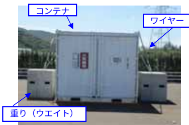
コンテナの固縛対策
