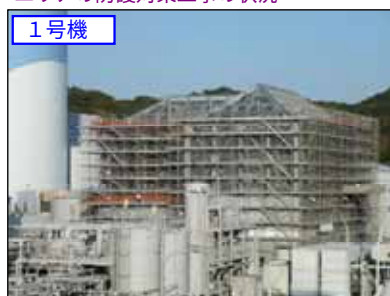
(2号機も同様に工事を実施中)
