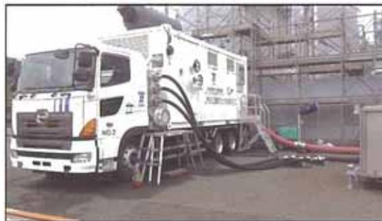
原子炉冷却用の可搬型ディーゼル注入ポンプや仮設ホースの設置
