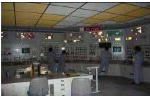
全交流電源喪失に至った場合を想定し、訓練シミュレータで、照明を消灯した中での緊急時運転操作訓練
