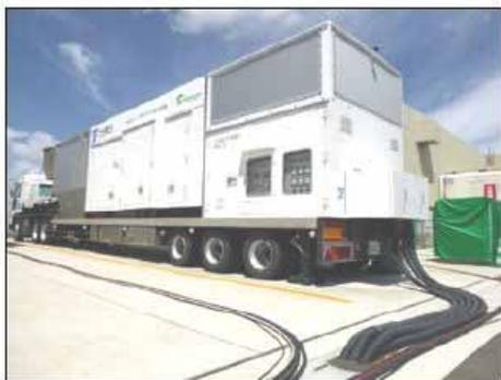
大容量空冷式発電機等による電源供給や電源ケーブルの布設
