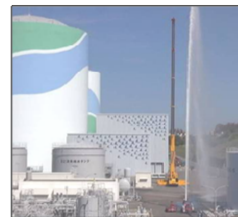
◇放水砲による放水
