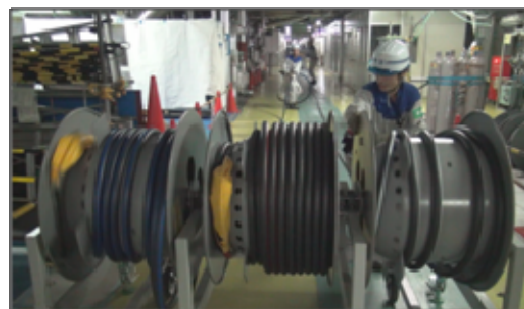
◇電源ケーブル敷設(屋内)
