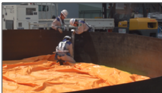
◇中間受槽(水槽)の設置
