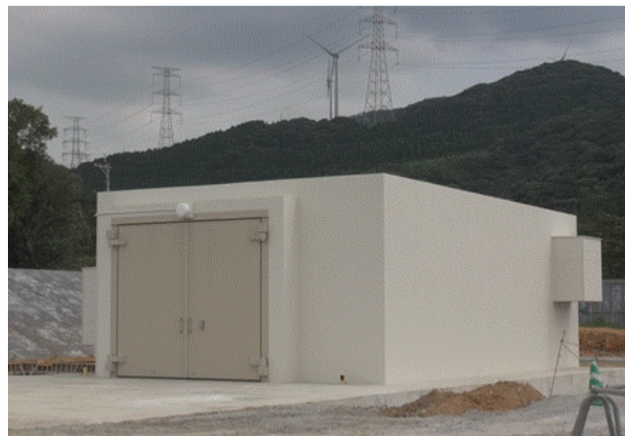
タンクローリ転倒防止のための車庫
