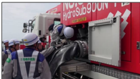
◇移動式大容量ポンプ車の設置
