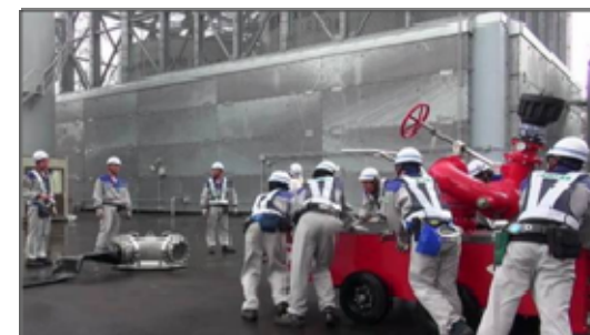
◇放水砲の設置
