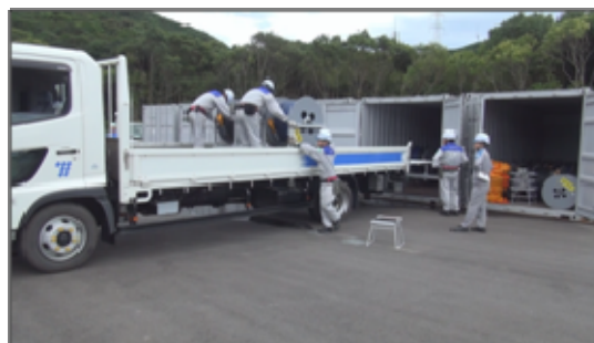
◇電源ケーブルの運搬
