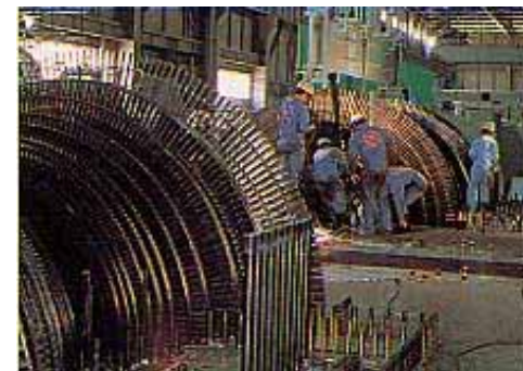
タービン開放点検・検査
