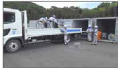
電源供給訓練
