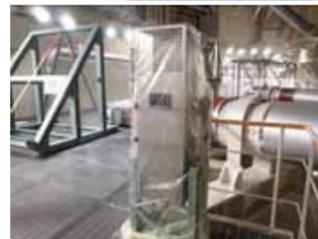
静的触媒式水素再結合装置
