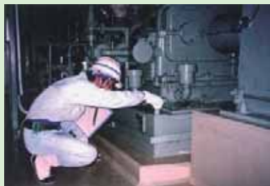
原子炉冷却系統ポンプ基礎ボルトの点検
