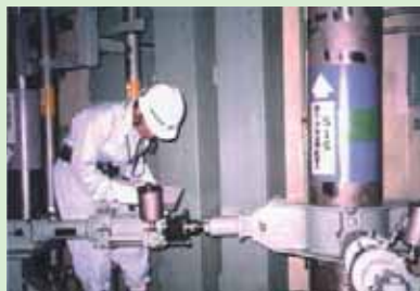
原子炉冷却系統配管支持装置の点検
