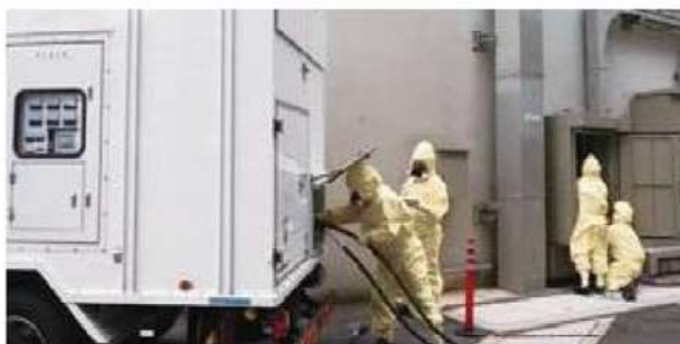
高圧発電機車の電源ケーブル接続
