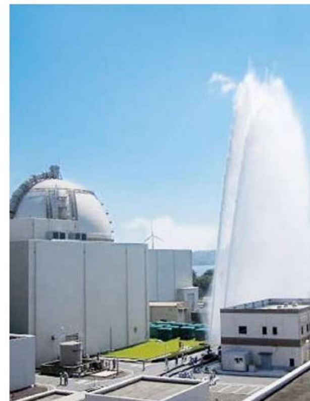
放水砲による放水
