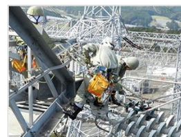
送電鉄塔・がいしの点検・修繕
