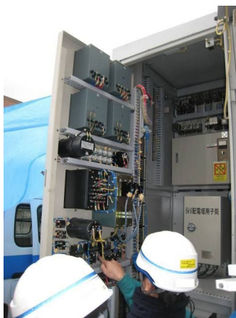
配電塔の現場点検
