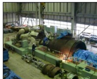
蒸気タービン点検作業
