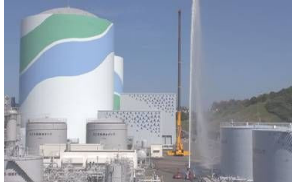
放水砲による放水訓練
