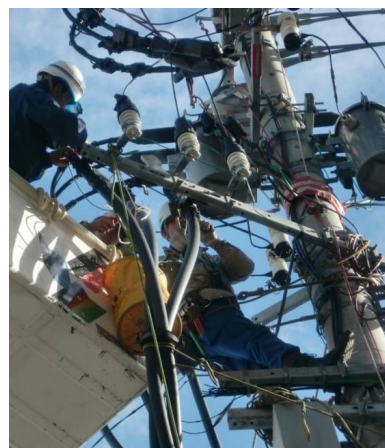
ケーブル端末部分の現場修理
