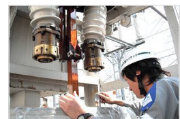
遮断器の点検・修繕
