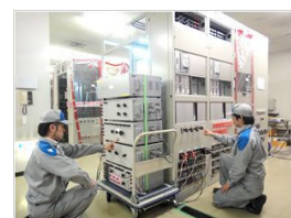
保護装置の点検・修理・試験
