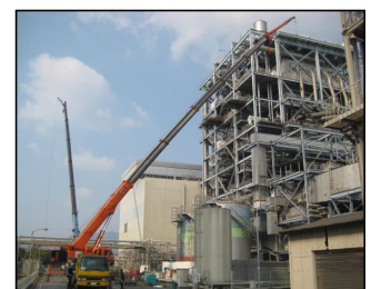
ボイラー点検作業
