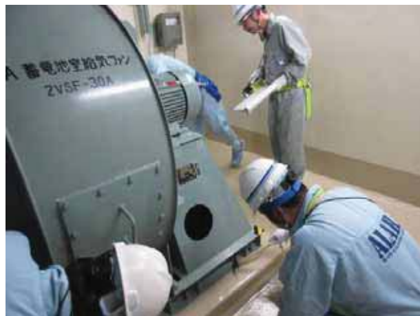
ファンの基礎ボルト点検
