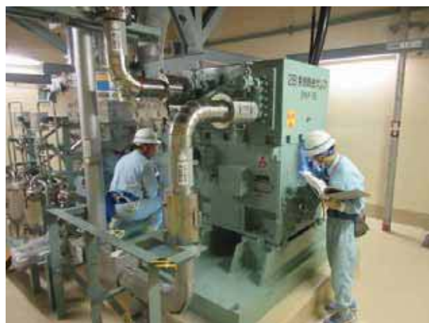
余熱除去ポンプ作動試験
