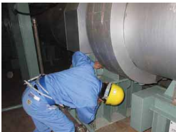
配管の支持装置点検
