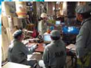
原子炉圧力容器点検
