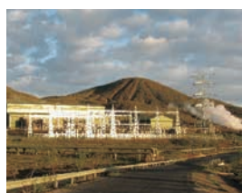
オルカリヤV地熱発電所(ケニア)
