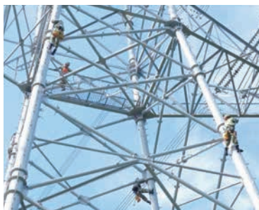
送電鉄塔の設備点検
