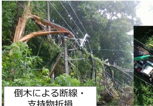
倒木による断線・支持物折損
