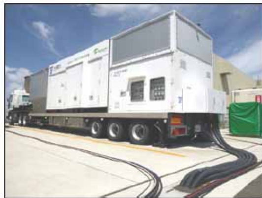
大容量空冷式発電機
