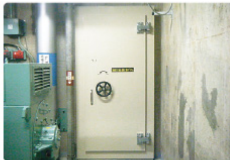
タービン動補助給水 ポンプ室の水密扉
