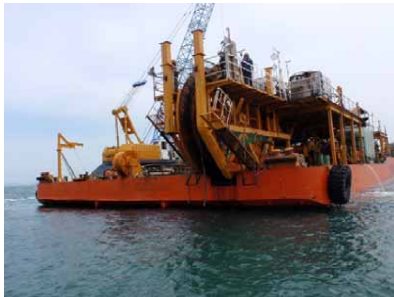
〔海底ケーブルの不良取替作業イメージ(H22年度施工)〕
