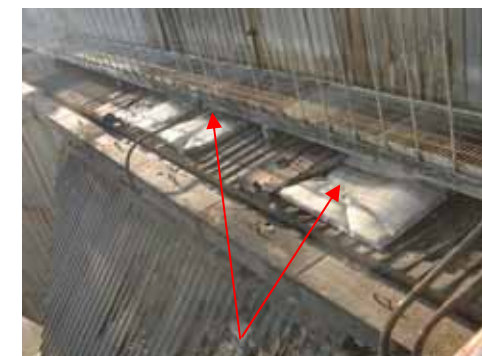
〔耐熱材による応急処置〕
