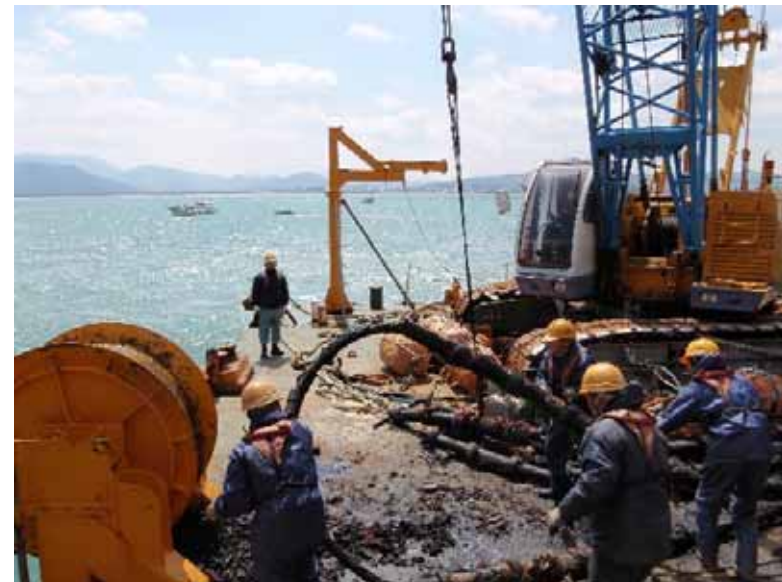
〔海底ケーブルの不良取替作業イメージ(H22年度施工)〕
