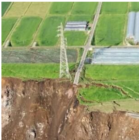
土砂崩れによる鉄塔被害
