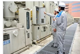
水力発電・変電設備の巡視
