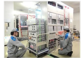
保護装置の点検・修理・試験
