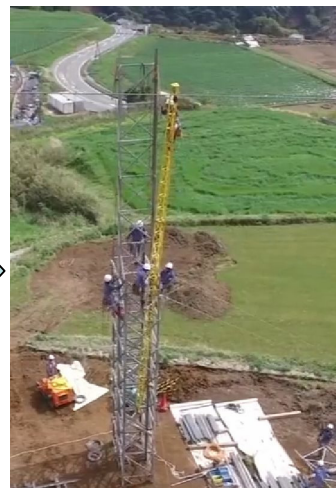
仮鉄柱構築作業
