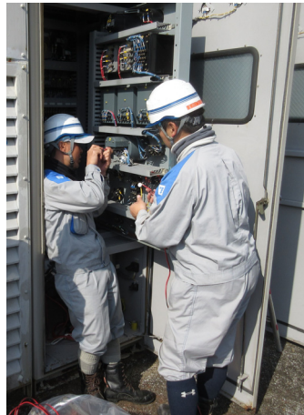
配電塔の現場点検
