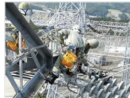
送電鉄塔・がいしの点検・修繕
