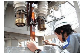
遮断器の点検・修繕
