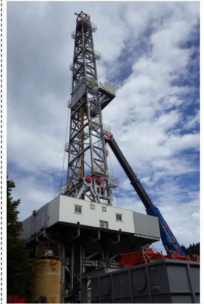
平治岳北部の調査用井戸掘削機
