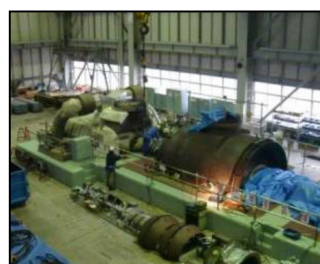
蒸気タービン点検作業
