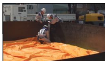
中間受槽（水槽）の設置
