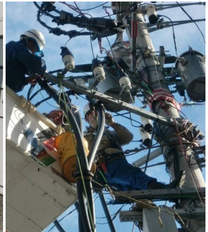
ケーブル端末部分の現場修理
