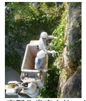
高所作業車を使った 城壁清掃
