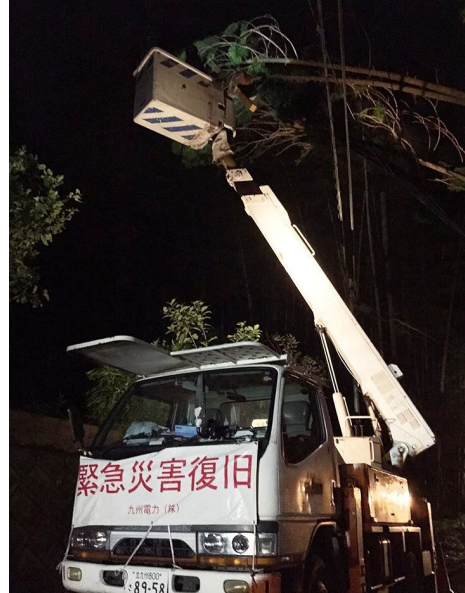
倒木除去による配電線の復旧作業
