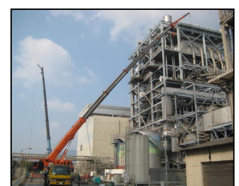
ボイラー点検作業
