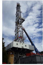
平治岳北部の調査用井戸掘削機
