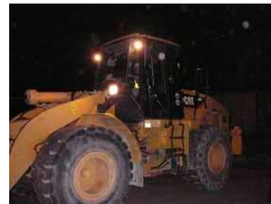
◇がれき撤去訓練(夜間)
