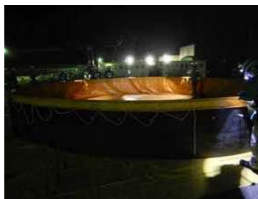
◇中間受槽設置(夜間)
