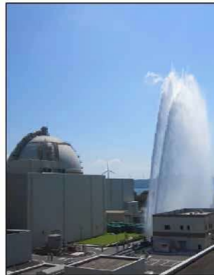
放水砲による放水訓練
