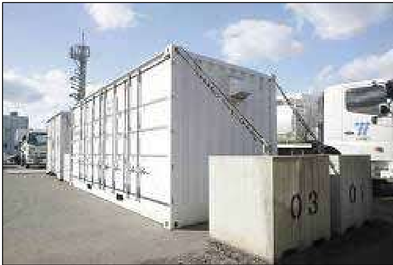
資材保管用コンテナの固縛
