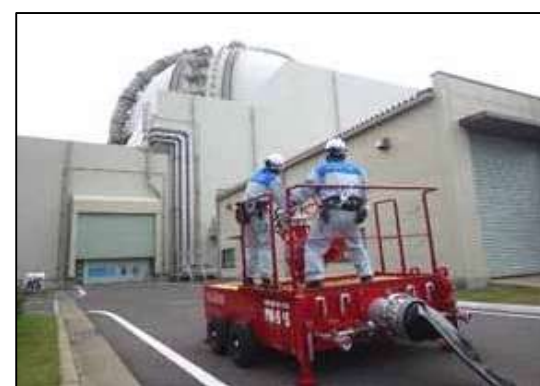
◇放水砲の設置
