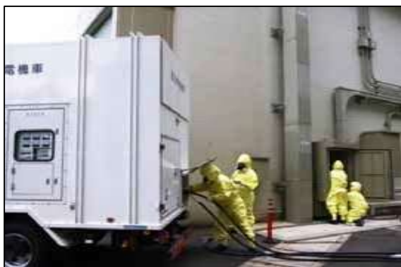
◇高圧発電機車の電源ケーブル接続 (汚染防護具着用)
