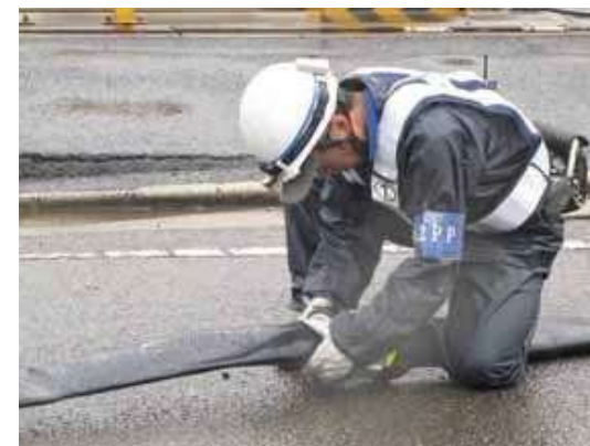
◇冷却水供給(ホース繋ぎ込み) (雨天時)
