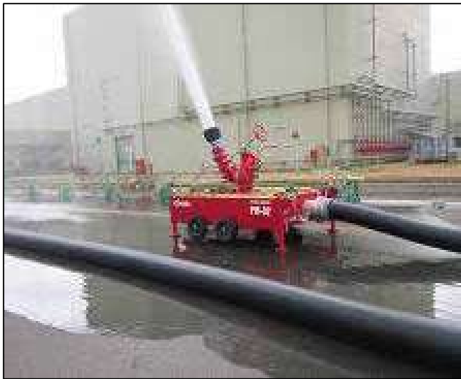
放水砲の設置
