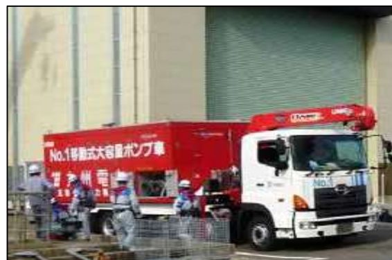
◇移動式大容量ポンプ車の設置
