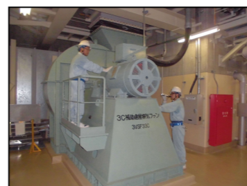
運転中機器(補助建屋排気ファン)の点検
