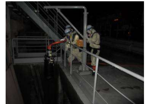
取水用水中ポンプの現場設置訓練
