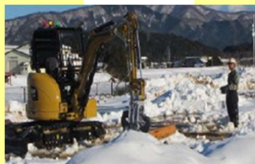
無線重機訓練
