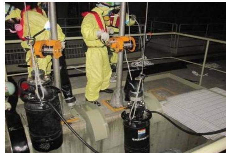
取水用水中ポンプの設置訓練
