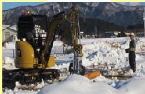
無線重機訓練
