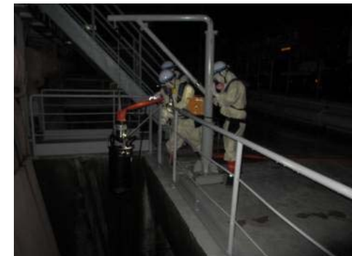
取水用水中ポンプの設置訓練
