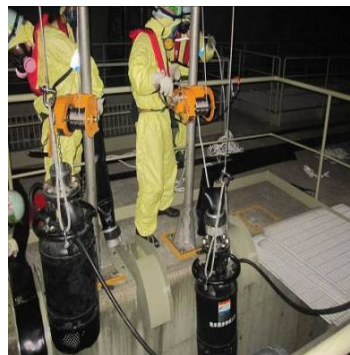
取水用水中ポンプの現場設置訓練
