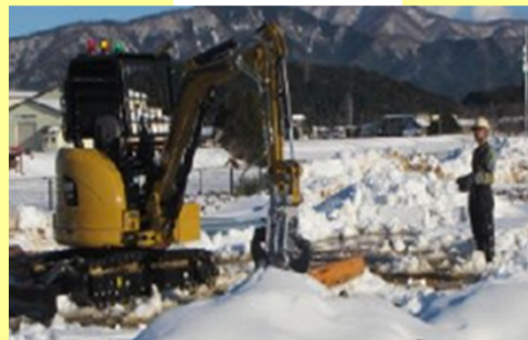
無線重機訓練
