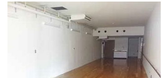
(放射線防護対策施設)
