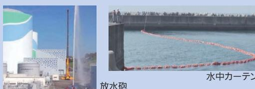
万が一の原子炉格納容器の破損に備え、放水砲や水中カーテンを配備。
