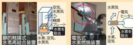
原子炉格納容器の冷却手段の多様化に加え、水素濃度の低減策として水素除去装置を配備。
