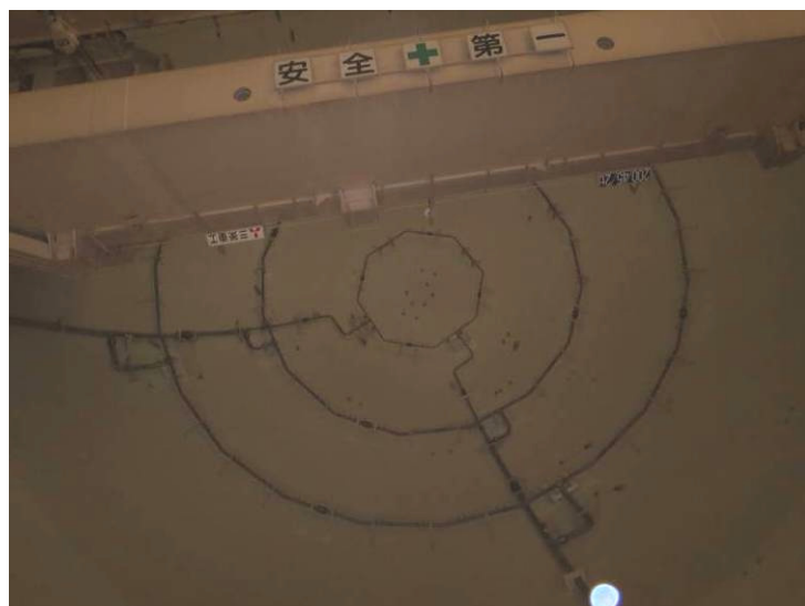
格納容器スプレイ配管点検
