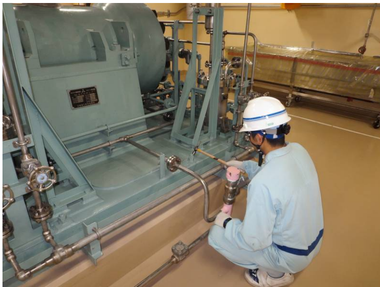
ポンプの基礎ボルト点検
