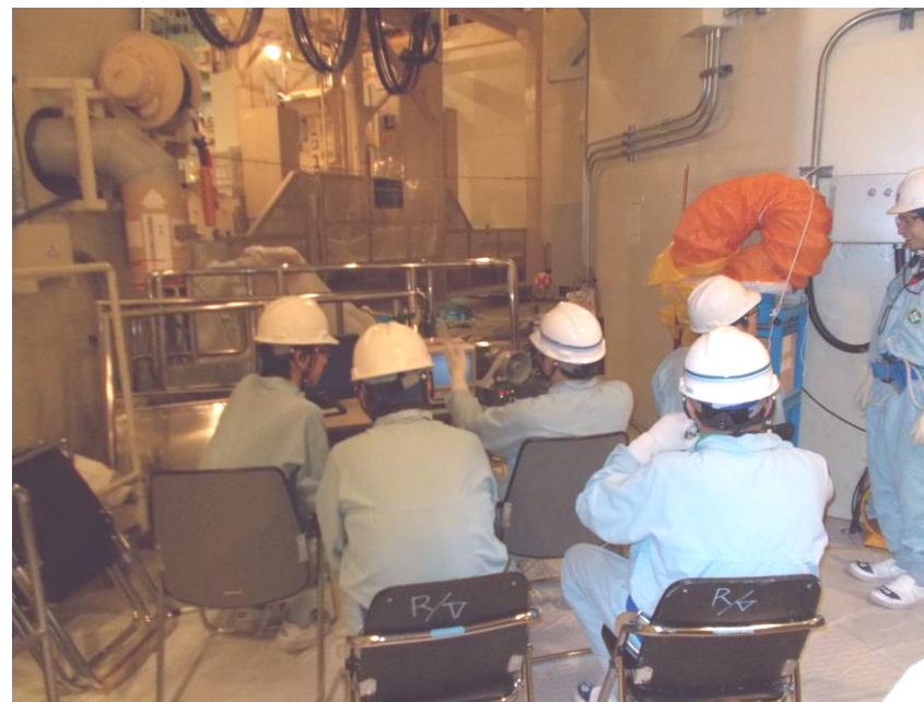
原子炉圧力容器内点検(撮影映像確認)
