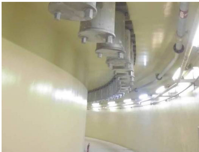
プレストレストコンクリート製格納容器点検
