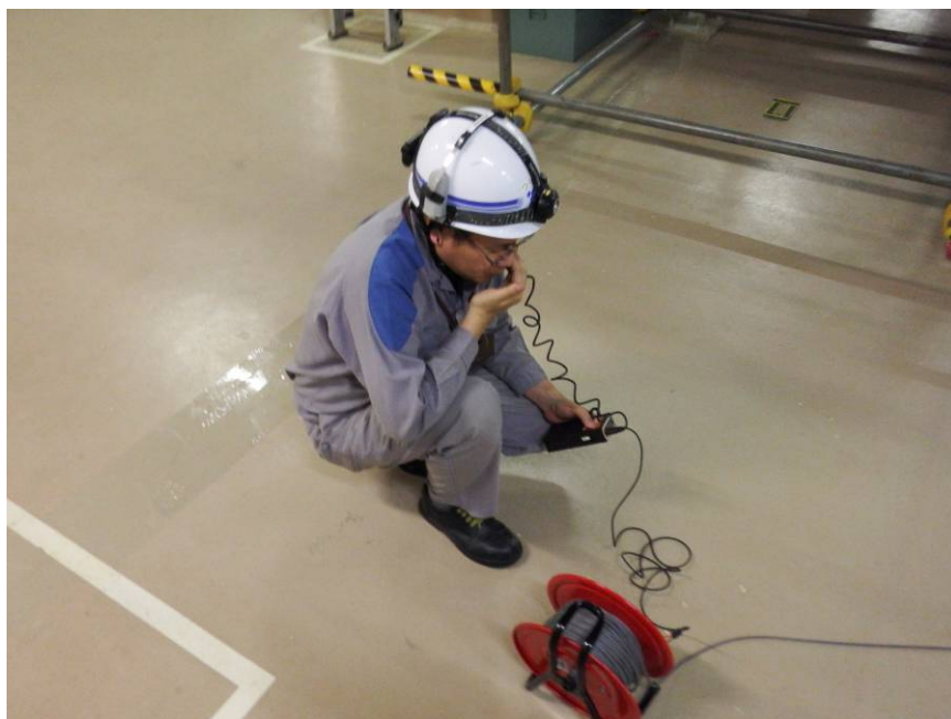
通信機器点検(通話装置)
