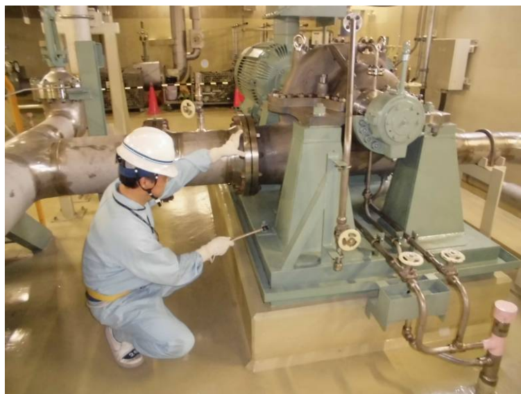
基礎ボルト点検
