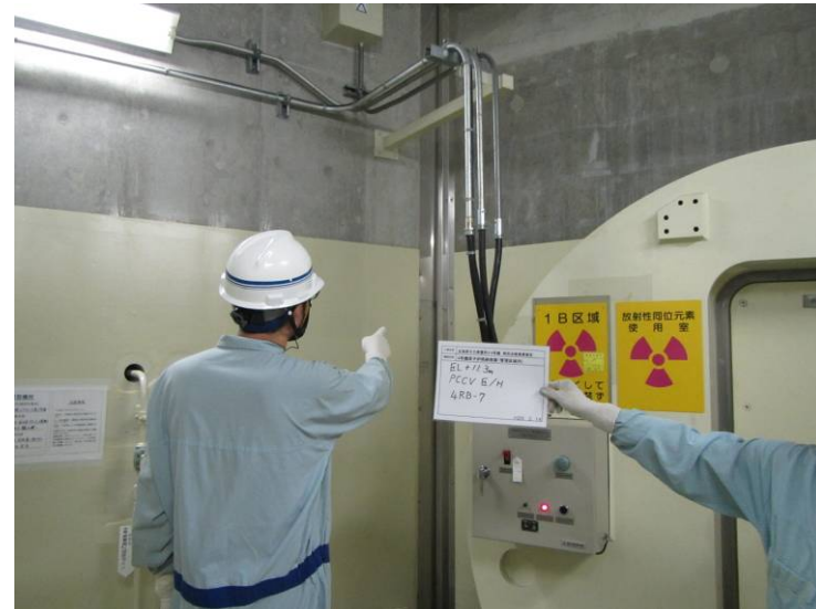
コンクリート構造物点検
