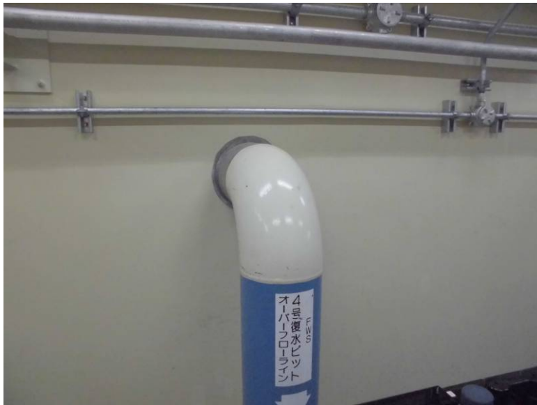
復水ピット点検
