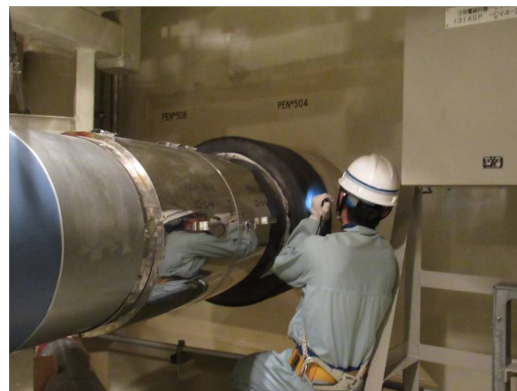
格納容器貫通部点検
