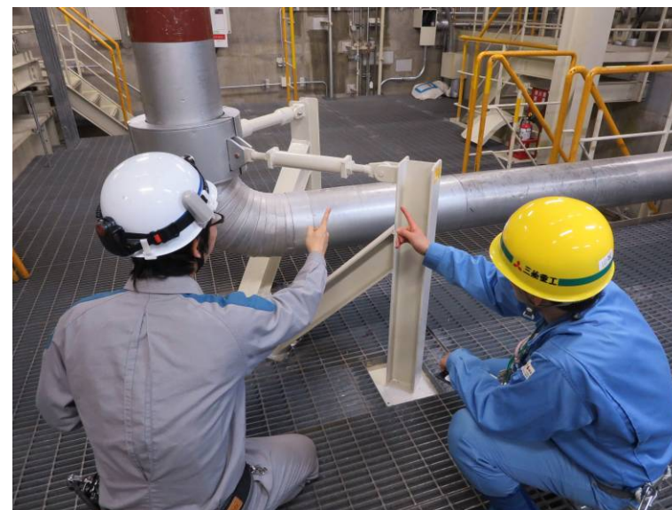
配管の支持装置点検
