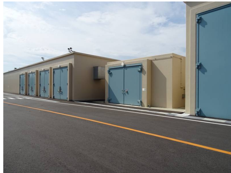
重大事故等対処設備保管庫点検
