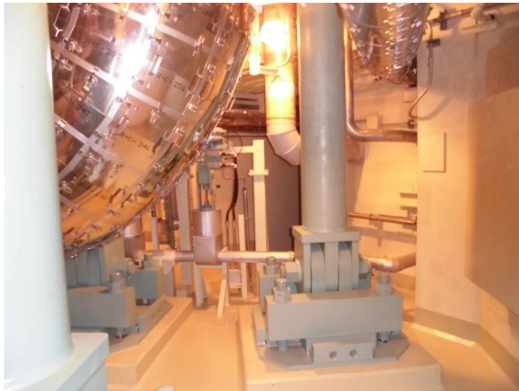
蒸気発生器支持構造物点検
