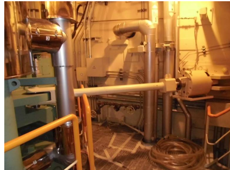
1次冷却材ポンプ支持構造物点検
