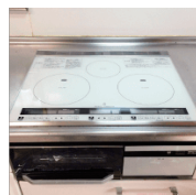
ガスコンロを外した 枠にIHをはめ込み、 完成!
