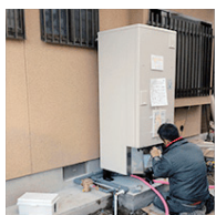
エコキュート据付
