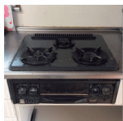
施工前 (ガスコンロ)
