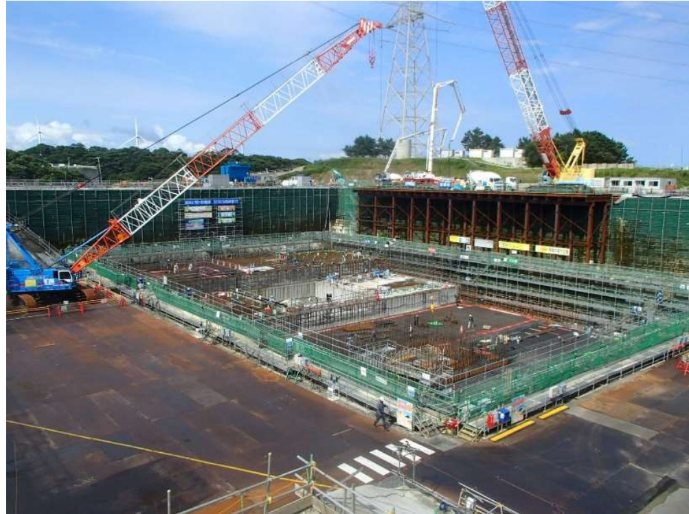
工事状況（2021年5月着工）
