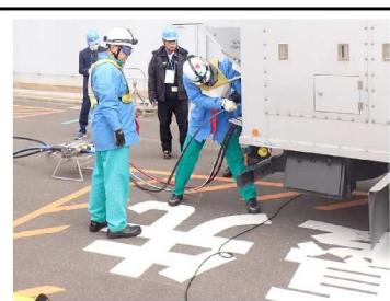
電源車へのケーブル接続
