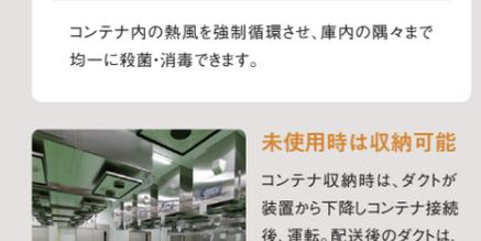
コンテナ収納時は、ダクトが装置から下降しコンテナ接続後、運転。配送後のダクトは、装置内に格納し、未使用時も邪魔になりません。
