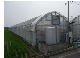
ヒートポンプ設置ハウス
