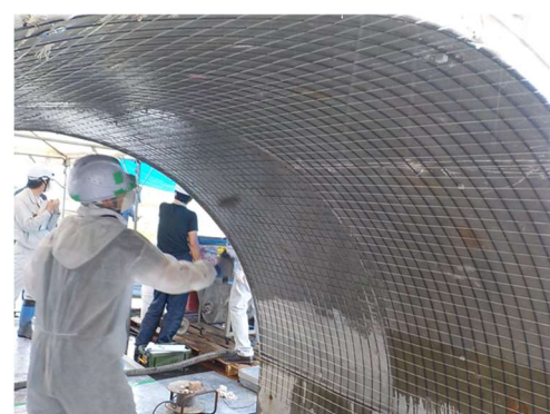
試験施工の様子
