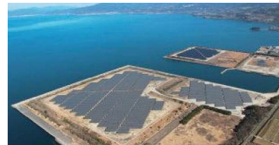
大村メガソーラー発電所
