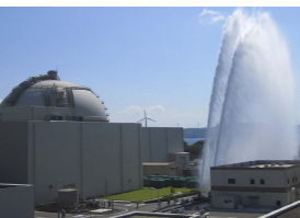
放水砲による放水
