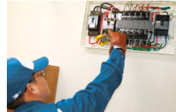
分電盤の点検
