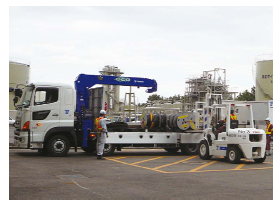
電源ケーブルの運搬
