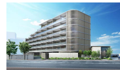
グランドオーク別府 碧のテラス (2024年8月竣工)
