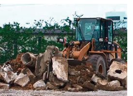
重機によるがれき撤去
