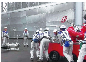
放水砲の設置
