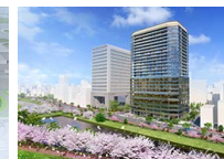
福岡家庭裁判所跡地活用事業 (2029年度竣工予定)
