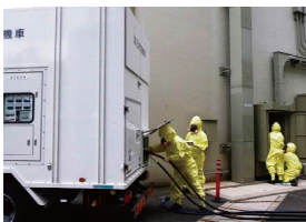
高圧発電機車の電源ケーブル接続
