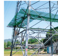
送電鉄塔の昇塔防止装置の設置
