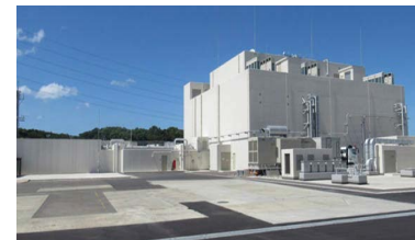
緊急時対策棟(川内)
