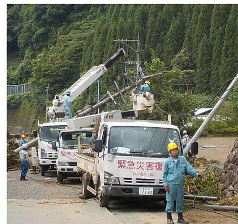
流木等で傾斜した電柱の引き起こし
