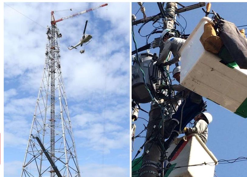
ヘリによる仮鉄塔架線作業
