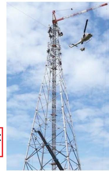
ヘリによる仮鉄塔架線作業
