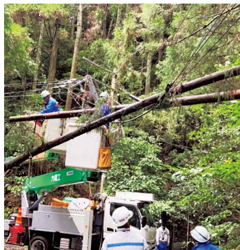
2024年台風10号での復旧作業の様子
