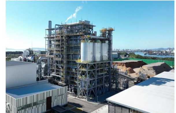
(広畑バイオマス発電所/2023年11月撮影)
