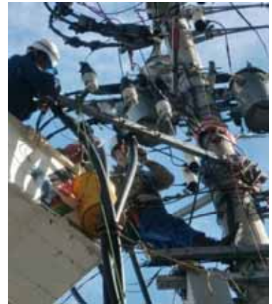
ケーブル末端部分の現場修理
