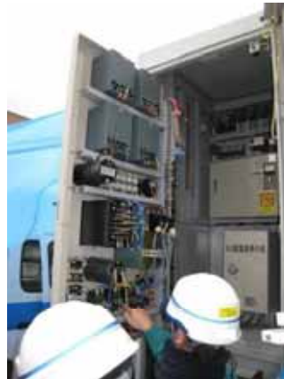
配電塔の現場点検
