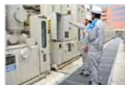
水力発電・変電設備の巡視
