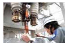
遮断器の点検・修繕
