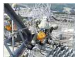
送電鉄塔・がいしの点検・修繕
