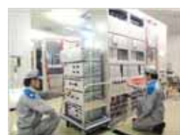
保護装置の点検・修理・試験
