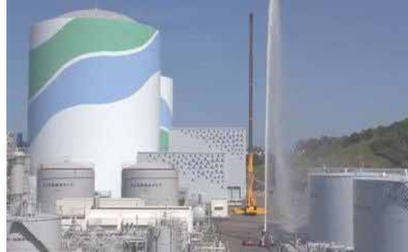
放水砲による放水訓練
