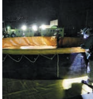
中間受槽の設置(夜間)
