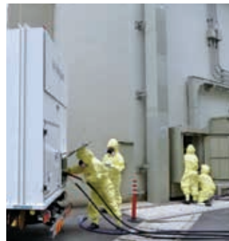
高圧発電機車の 電源ケーブル接続
