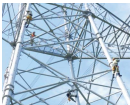
送電鉄塔の設備点検
