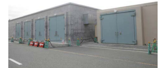
資機材等を収納する保管庫(玄海)
