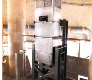
静的触媒式水素再結合装置
