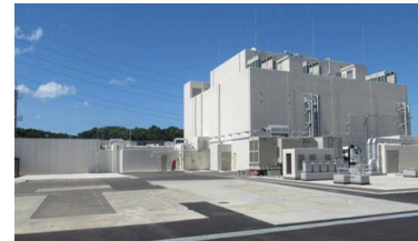
緊急時対策棟(川内)
