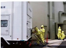
高圧発電機車の電源ケーブル接続
