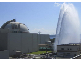
放水砲による放水
