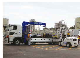
電源ケーブルの運搬
