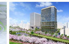
福岡家庭裁判所跡地活用事業 (2029年度竣工予定)
