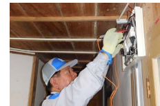
屋内配線診断（熊本配電事業所）
