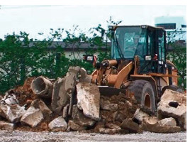
重機によるがれき撤去
