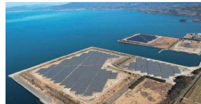
大村メガソーラー発電所
