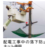
配電工事中の落下防止ネット使用
