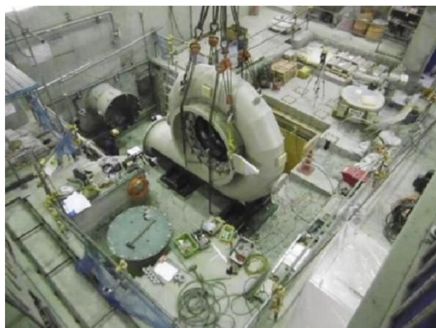
水力発電所の更新工事【小鹿野発電所（鹿児島県）】 （水車吊り込み状況）
