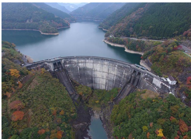
水力発電所の維持管理[上椎葉発電所]（宮崎県）
