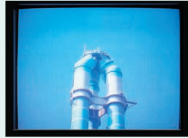
排煙監視モニター
