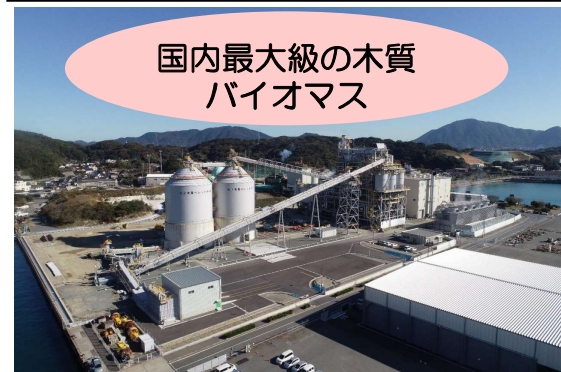
下関バイオマス発電所(2022年2月運開)
