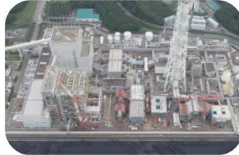
【建設中の松浦発電所2号】
