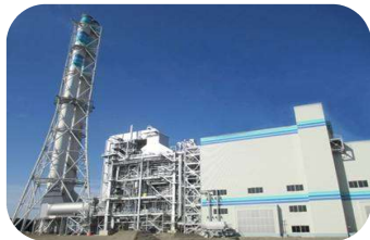
【新大分発電所3号系列4軸】
