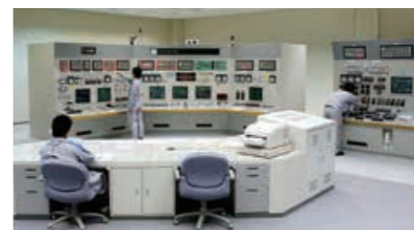
シミュレータ室(3,4号機用)
