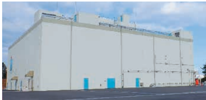
緊急時対策棟外観
