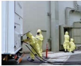
高圧発電機車の電源ケーブル接続
