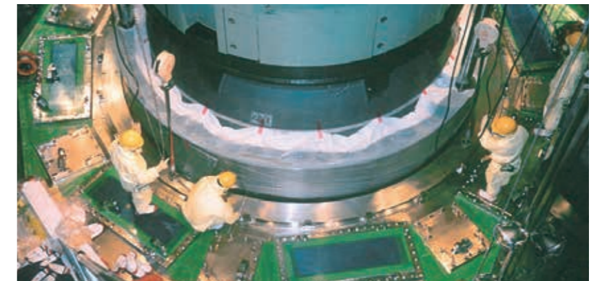
原子炉容器蓋取外し作業
