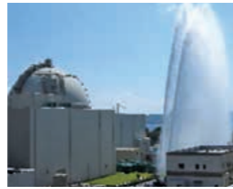
放水砲による放水
