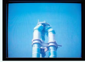
排煙監視モニター
