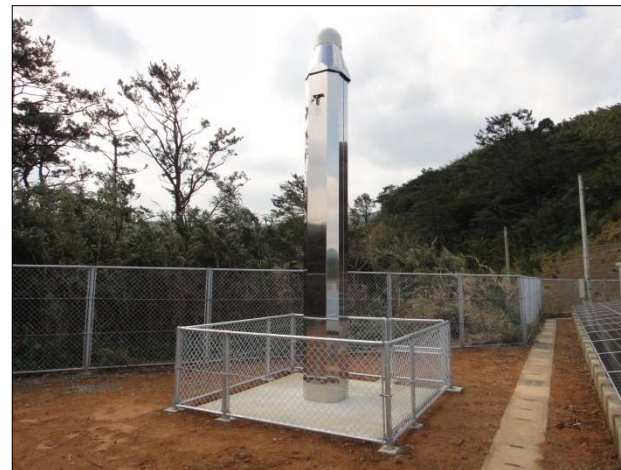
黒島の機器設置状況
