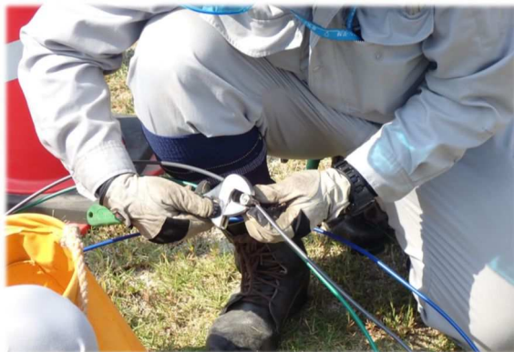
他の一般送配電事業者の資材 による復旧訓練
