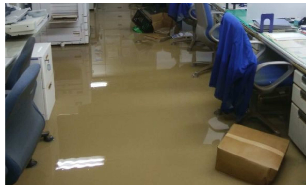
人吉配電事業所 1階フロア床上浸水 (50cm浸水)
