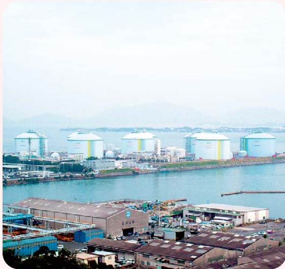
※ L N G : 〔Liquefied Natural Gas(液化天然ガス)〕 天然ガスを約マイナス162℃まで冷却して液体にしたもの。液化することで体積がガスのときの約600分の1になり、効率的に運搬できます。
