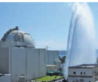
放水砲による放水
