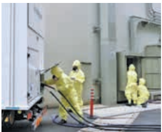
高圧発電機車の電源ケーブル接続
